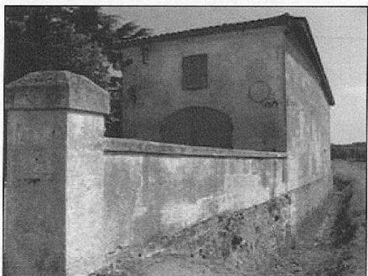
Bâtiment d'exploitation du Mayne
